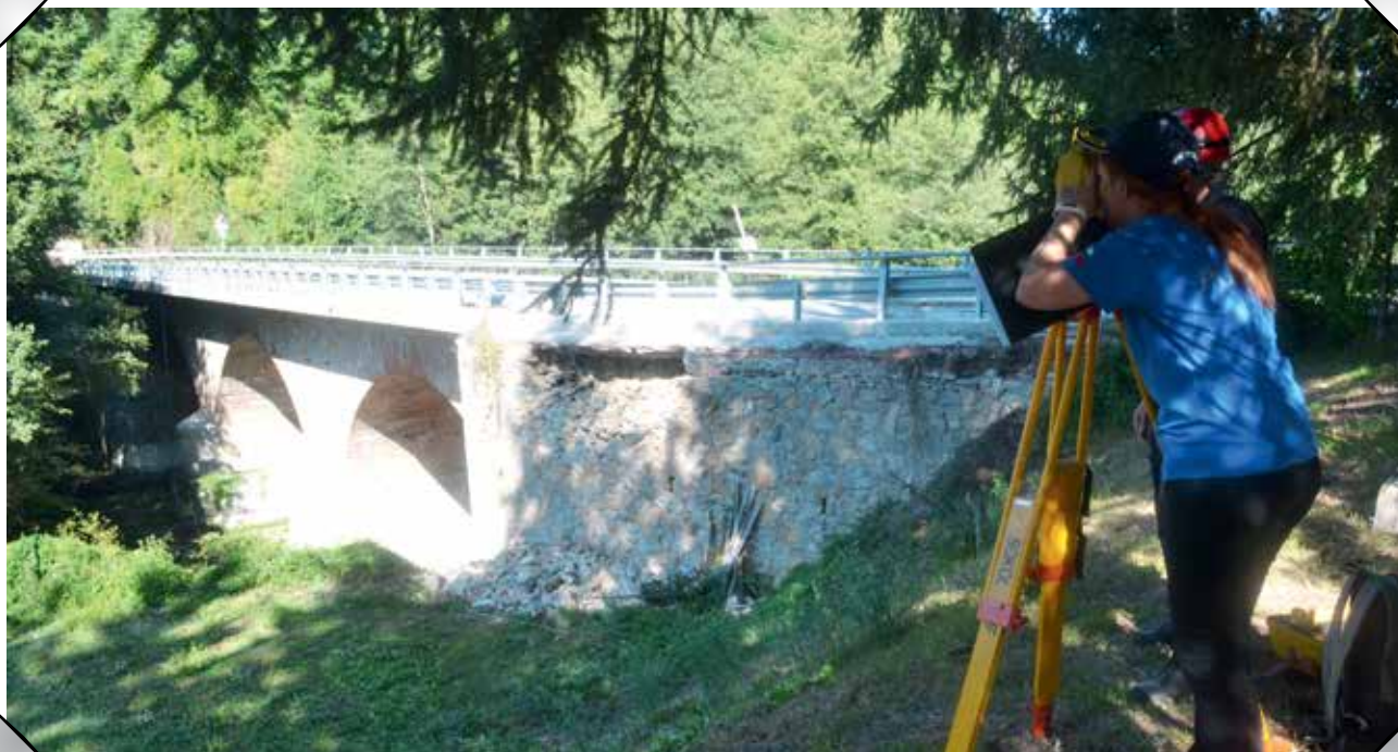
4 сентября 2016 г. Проведение геодезических измерений мостового сооружения в г. Аматриче, Италия
